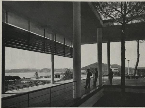
Luigi Cosenza, Piero Porcinai, Marcello Nizzoli, stabilimento Olivetti, Pozzuoli, 1951 sgg.
